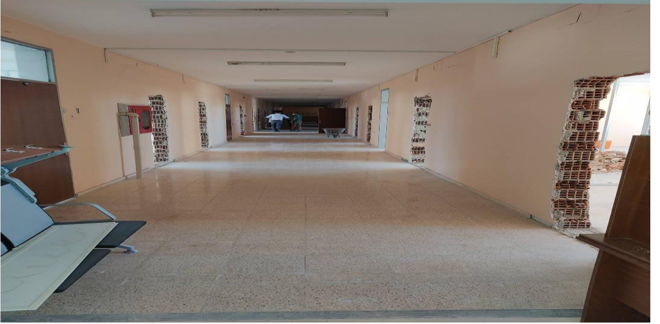
Fotoğraf 6) Bakım Onarım İşleri
