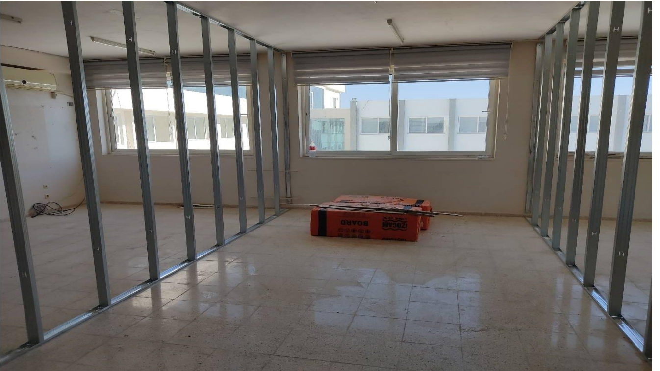
Fotoğraf 7) Bakım Onarım İşleri
