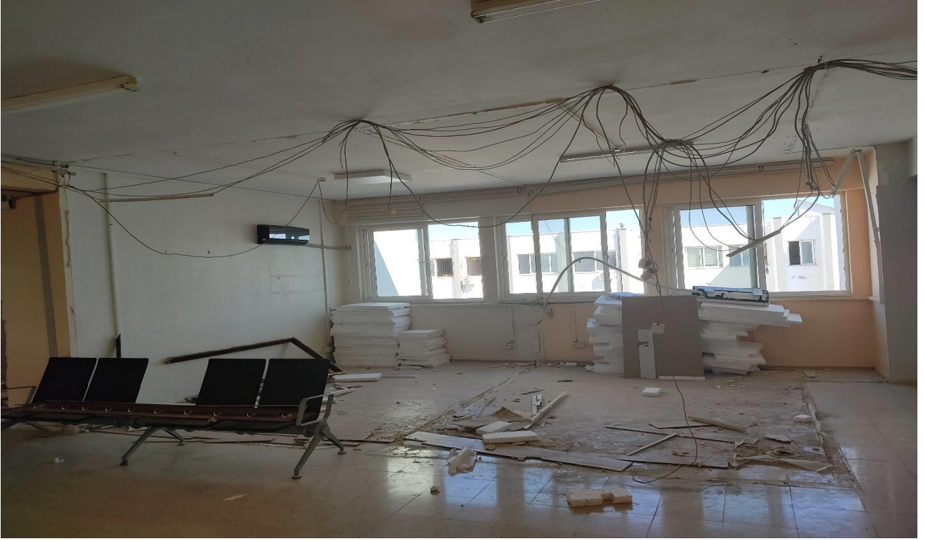
Fotoğraf 8) Bakım Onarım İşleri
