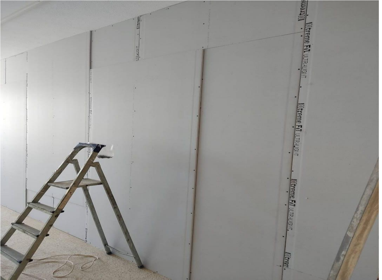
Fotoğraf 9) Bakım Onarım İşleri
