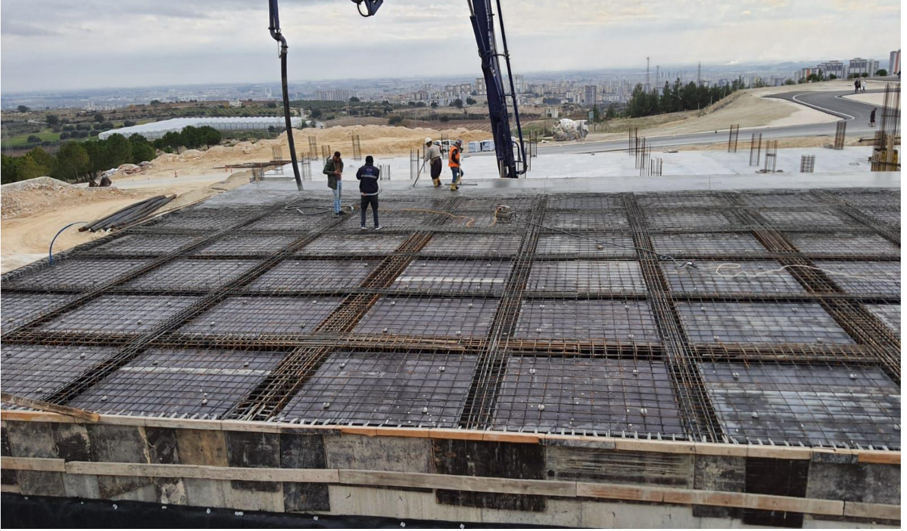
Fotoğraf 12) Tarsus Üniversitesi Mühendislik Fakültesi Yapım İşi
